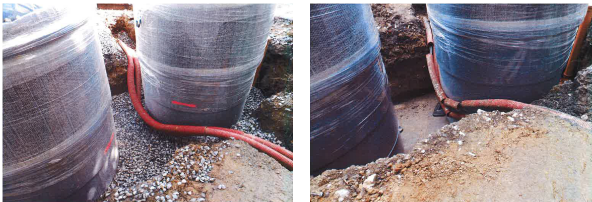
Fotodokumentace průběhu sdělovacích kabelů v místě stavby
