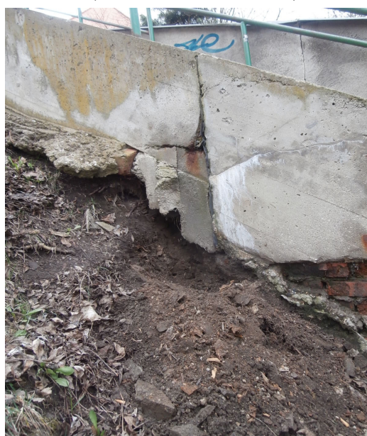
Foto 5 – pohled na spodek žb desky nosné konstrukce schodiště, vpravo otvor vybouraný v cihelné stěně tl. 15 cm a nad ním rozpadlá hlavní výztuž žb schodnice (dtto foto 4 z exteriéru)
