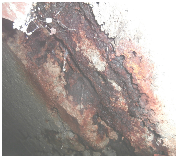
Foto 4 – zkorodovaná hlavní výztuž schodnice žb konstrukce schodiště
