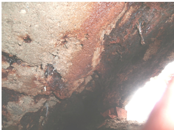
Foto 5 – pohled na spodek žb desky nosné konstrukce schodiště, vpravo otvor vybouraný v cihelné stěně tl. 15 cm a nad ním rozpadlá hlavní výztuž žb schodnice (dtto foto 4 z exteriéru)
