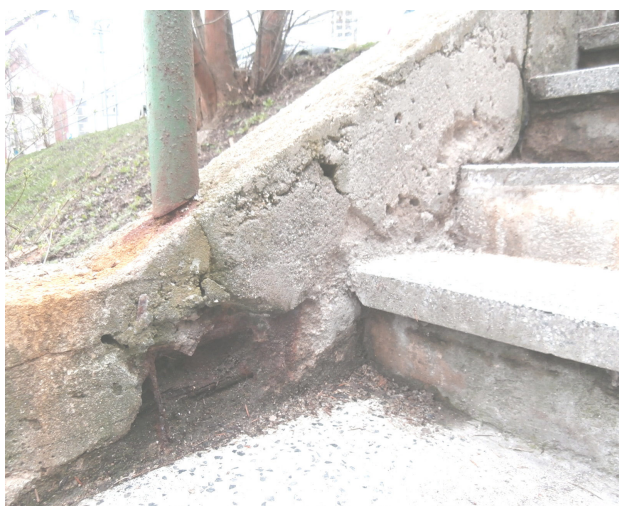
Foto 6 – poškozená schodnice žb konstrukce schodiště – rozpadlý beton odhalená výztuž
