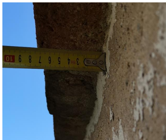
Přesahy koruny přes líc a rub svislé stěny
