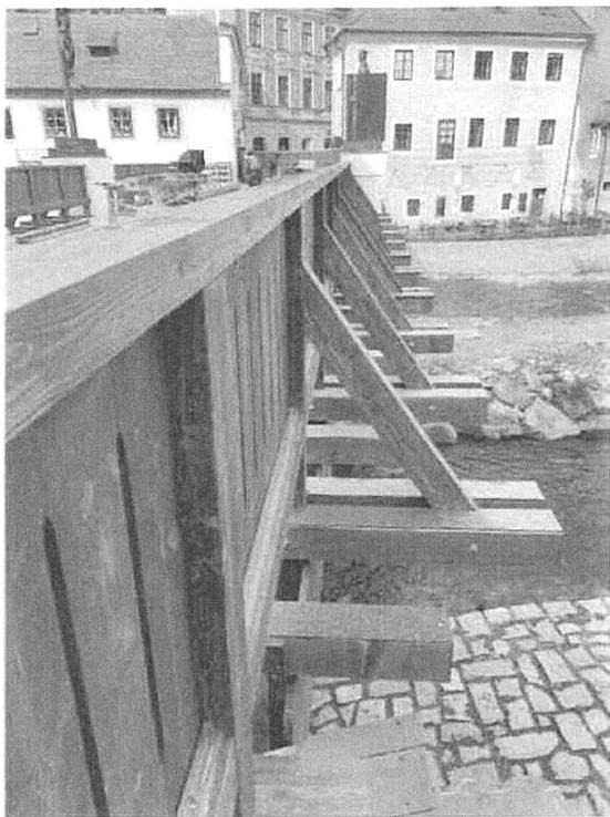
Zakrytí konzol zábradlí
