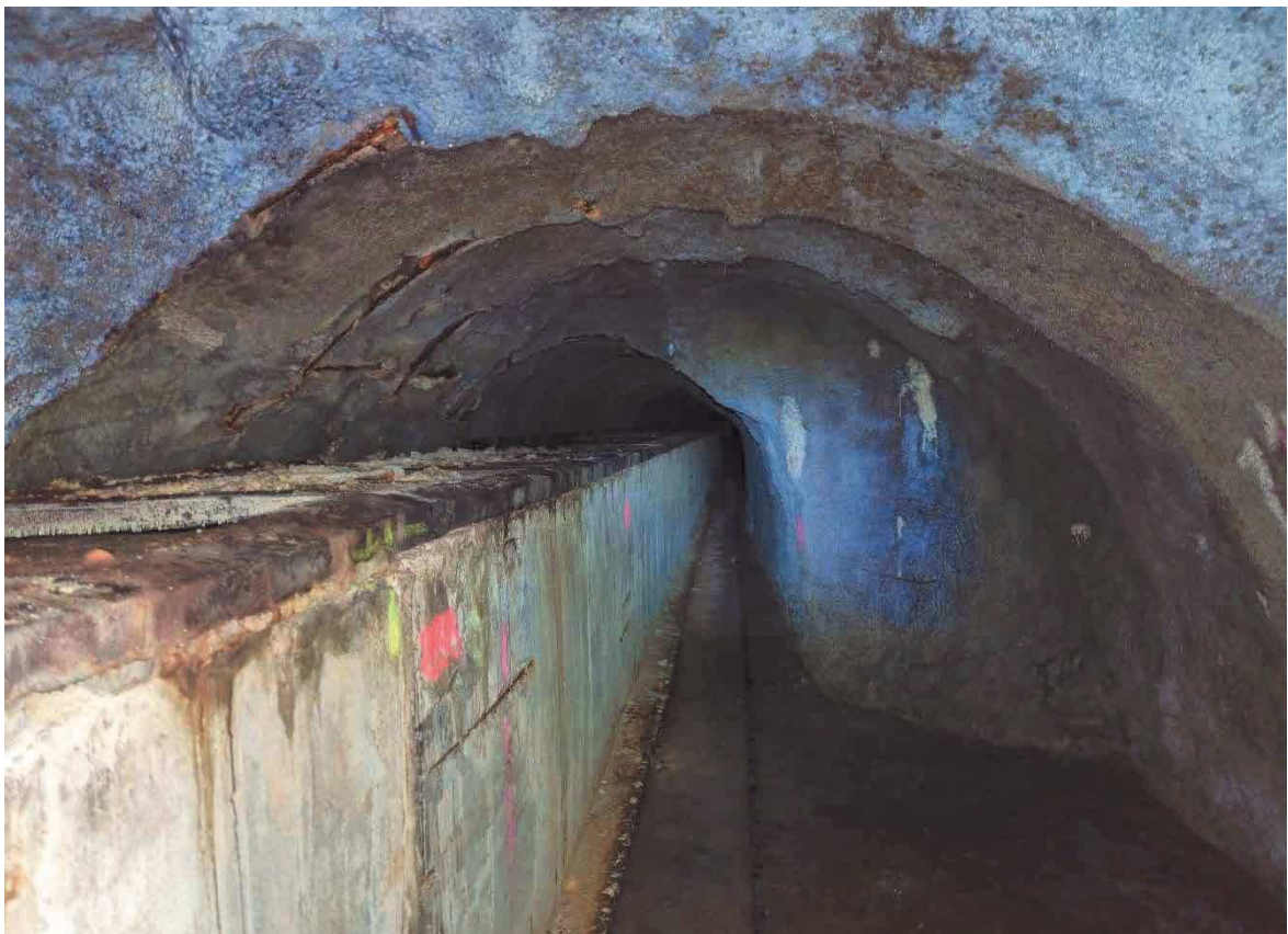
Obrázek 5: Obchvatný kanál Větřní - Č. Krumlov, Štola IV
