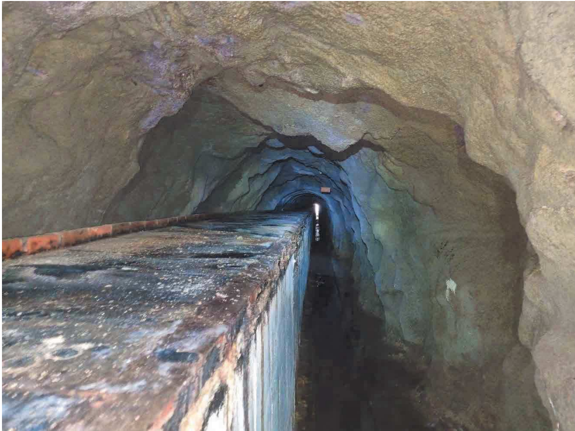
Obrázek 2: Obchvatný kanál Větrní - Č. Krumlov, Štola III
