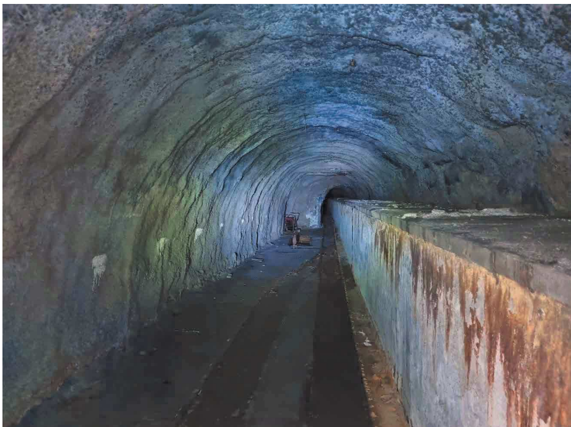
Obrázek 7: Obchvatný kanál Větrní - Č. Krumlov, Štola IV
