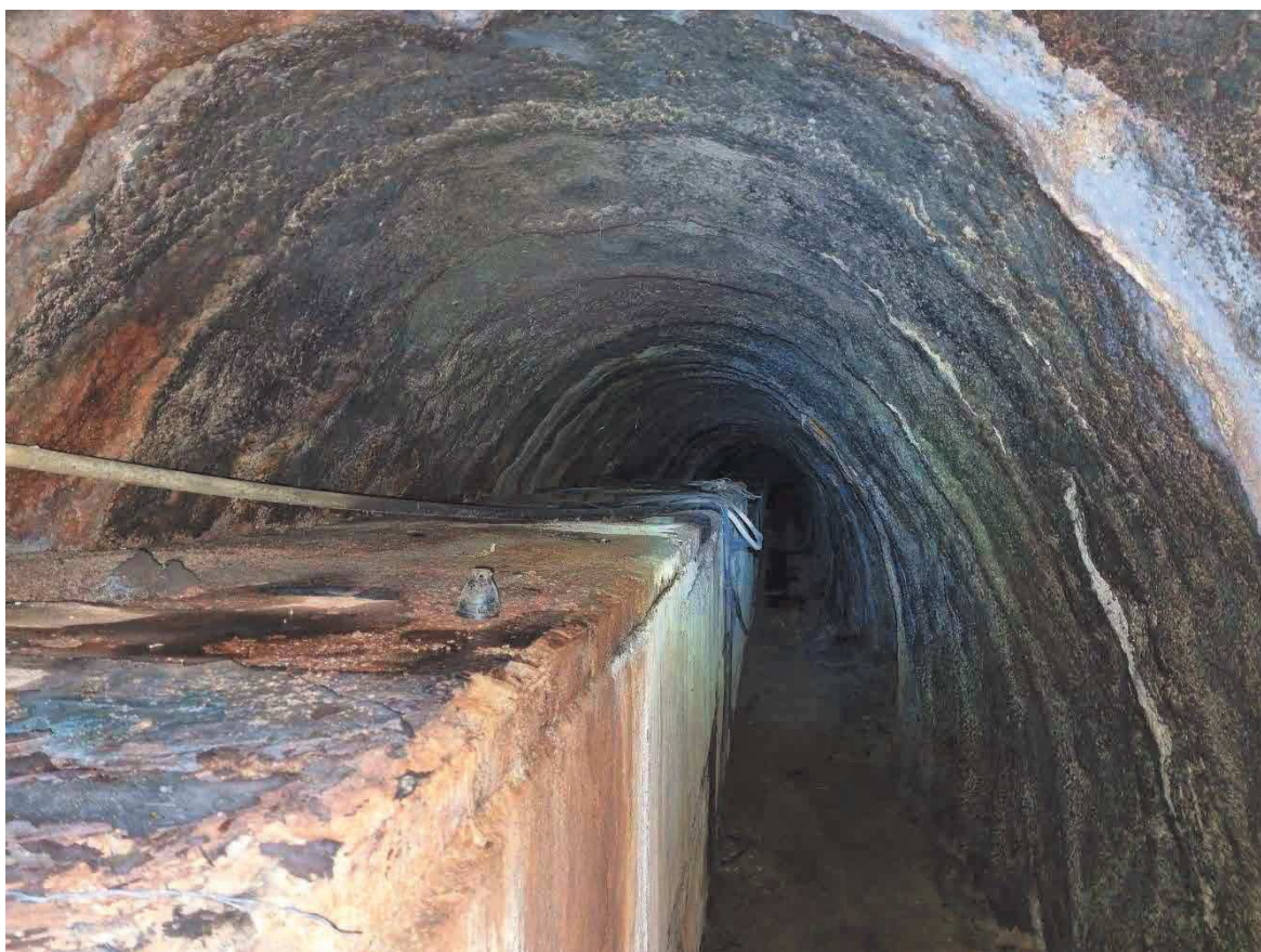
Obrázek 9: Obchvatný kanál Větrní - Č. Krumlov, Štola IV
