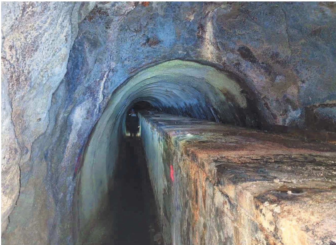
Obrázek 3: Obchvatný kanál Větrní - Č. Krumlov, Štola III
