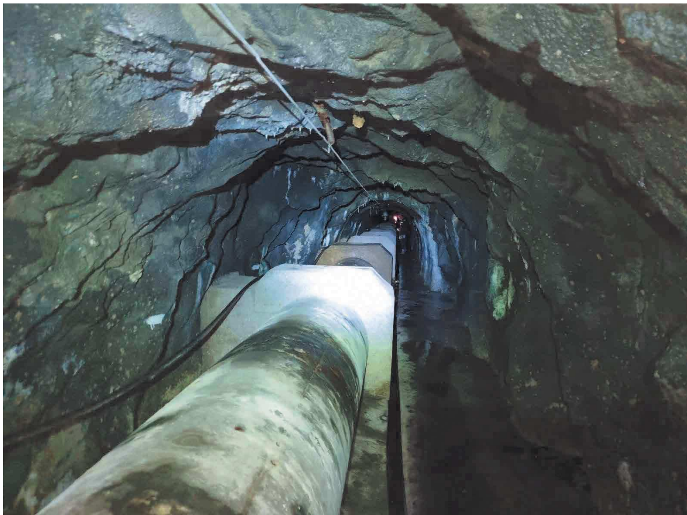
Obrázek 1: Obchvatný kanál Větřní - Č. Krumlov, Štola II
