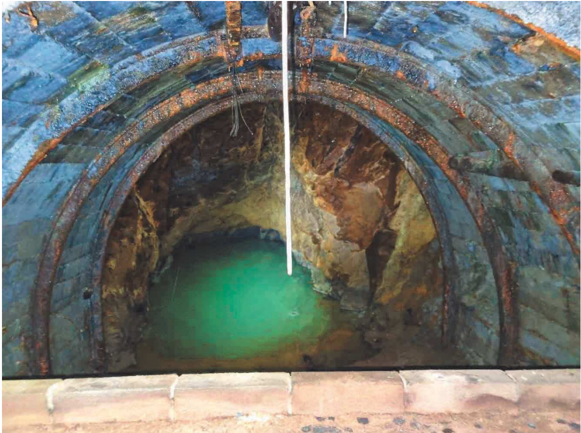
Obrázek 4: Obchvatný kanál Větřní - Č. Krumlov, přípojná větev
