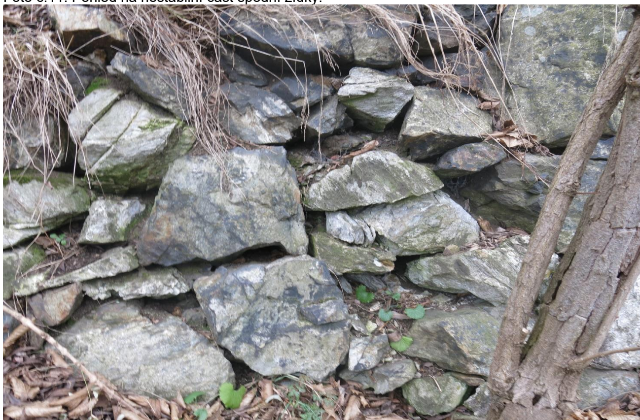
Foto č.12: Detailní pohled na část spodní opěrné zídky.
