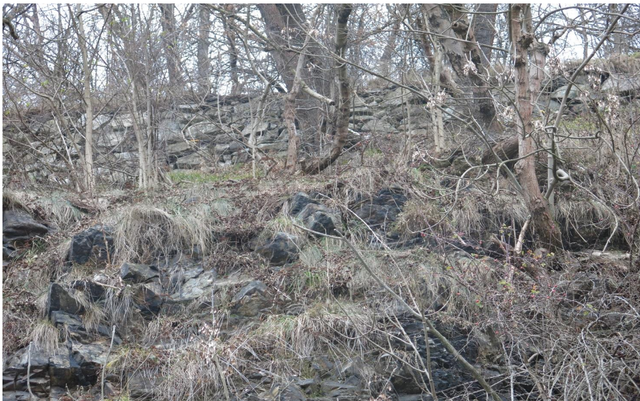
Foto č.3: Pohled na spodní zídku od silnice
