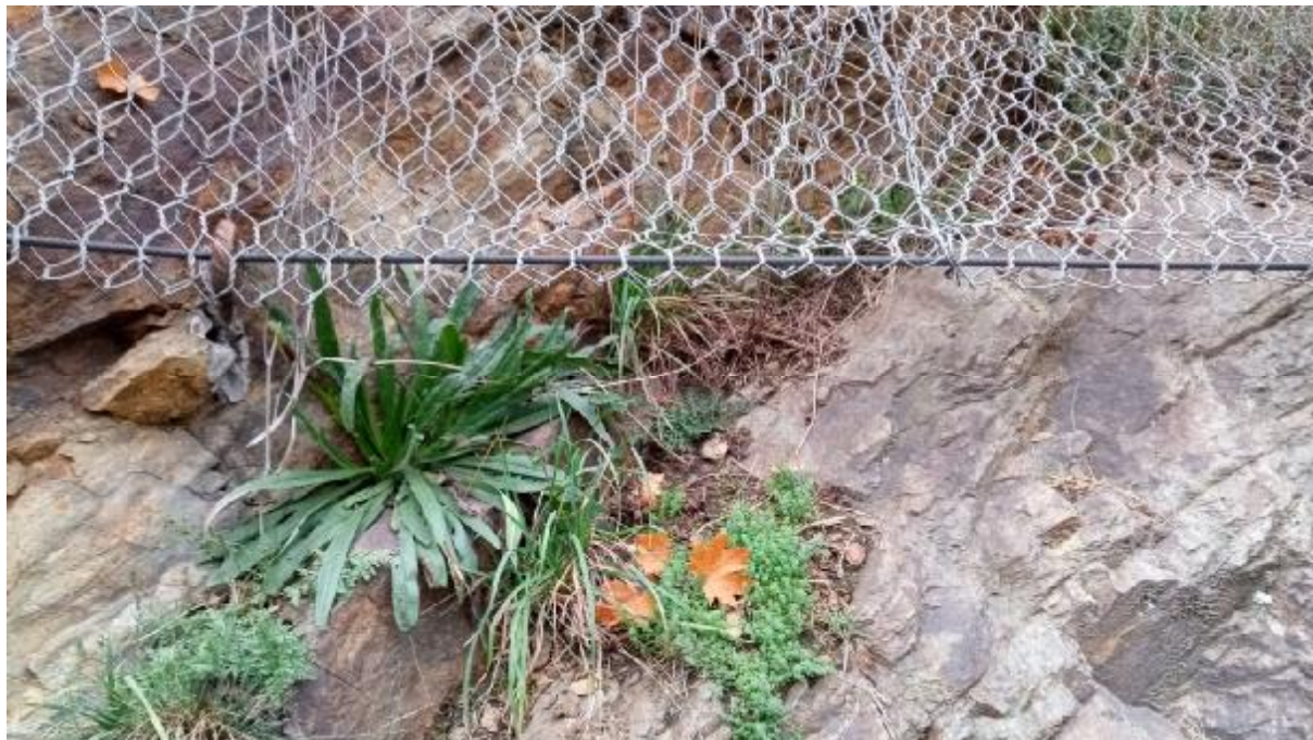
Obr. 8 Pohled na spodní horizont obvodového ocelového lana, který nedostatečně kopíruje morfologii terénu
