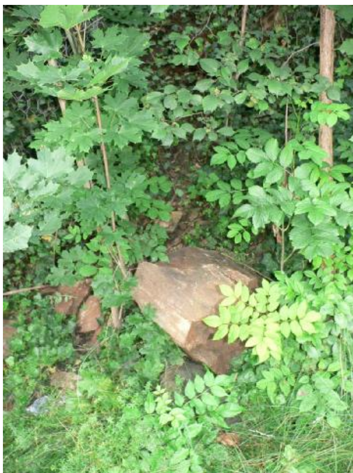
Obr. 24 Uvolněný skalní blok napravo od konce zajištění ocelovými sítěmi
