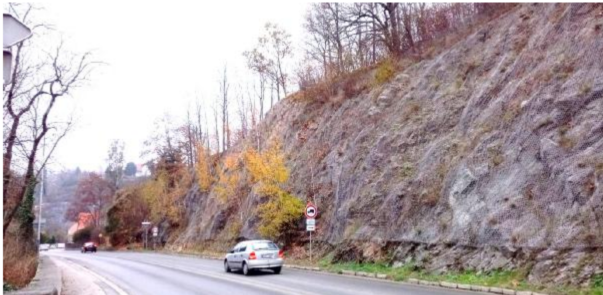
Obr. 2 Pohled na spodní část skalního svahu s revidovanými prvky zajištění
