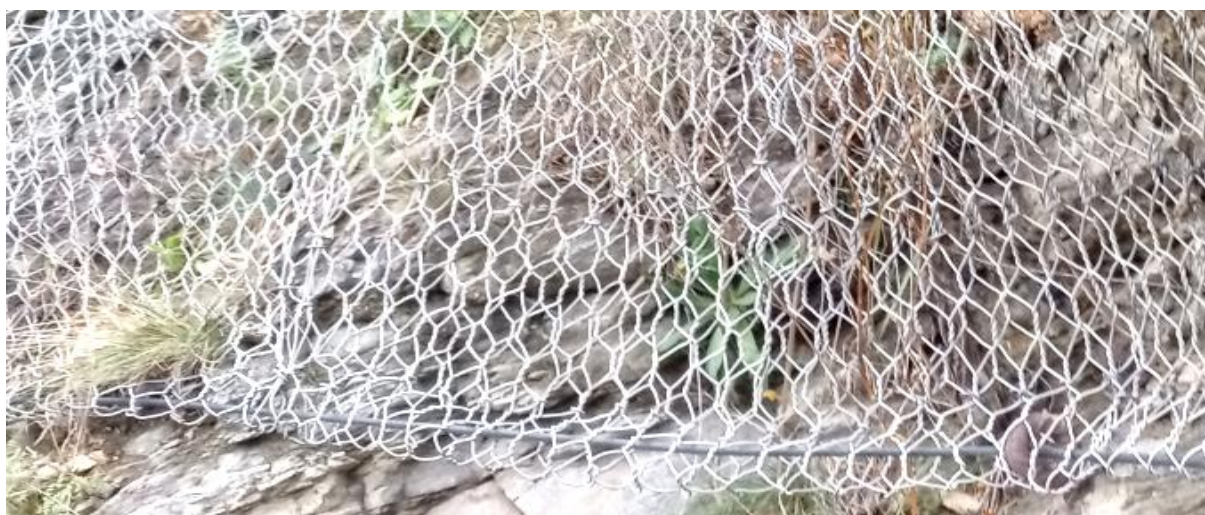
Obr. 3 Typ použité ocelové sítě (hexagonální pletivo s vel. oka 80 x 100 mm + PVC, tl. drátu 2,7/3,7 mm)
