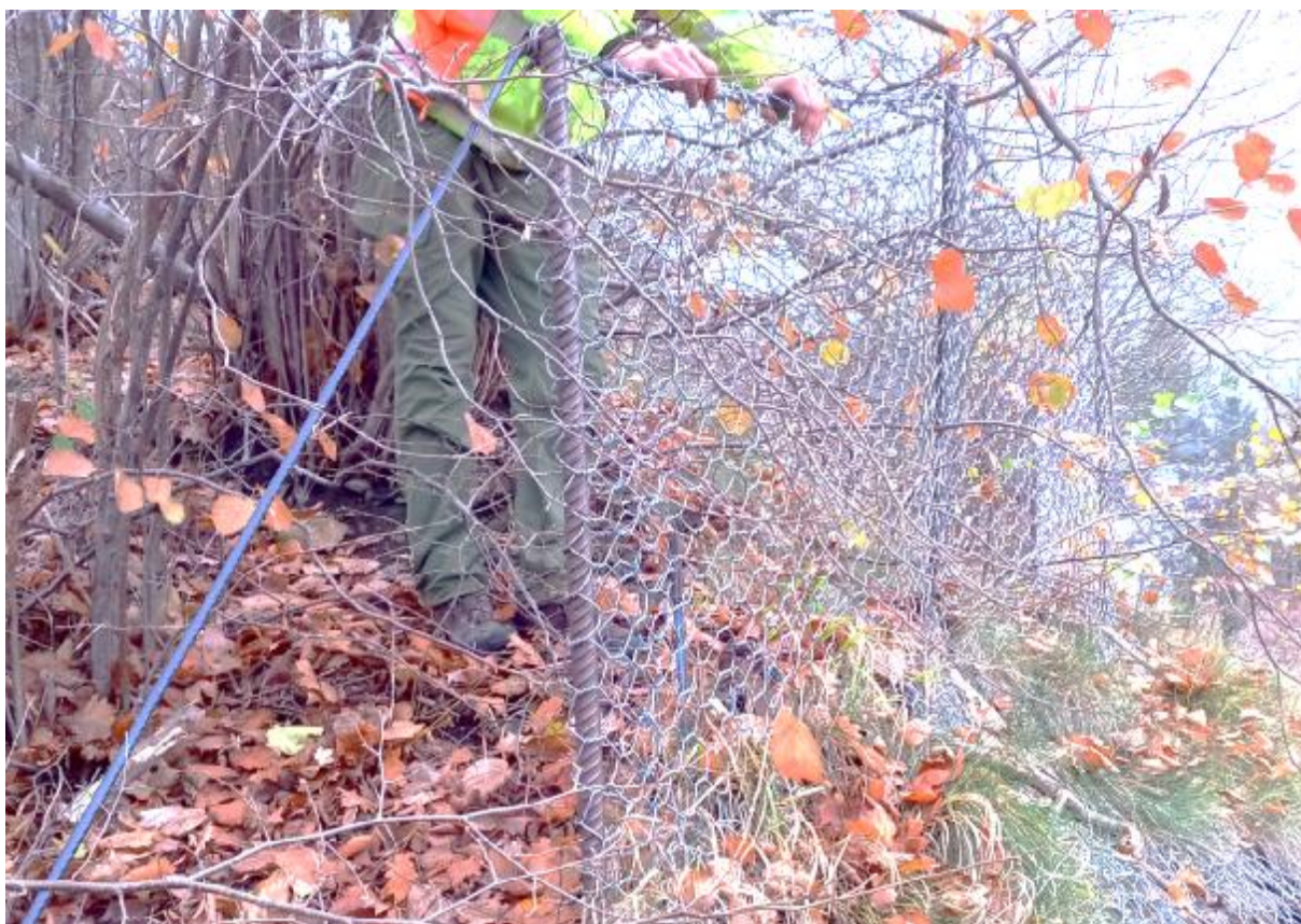
Obr. 5 Pohled na konstrukci záchytného plotu
