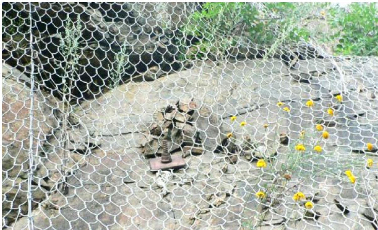
Obr. 21, 22, 23 Příklady menších akumulací sutě za ocelovými sítěmi
