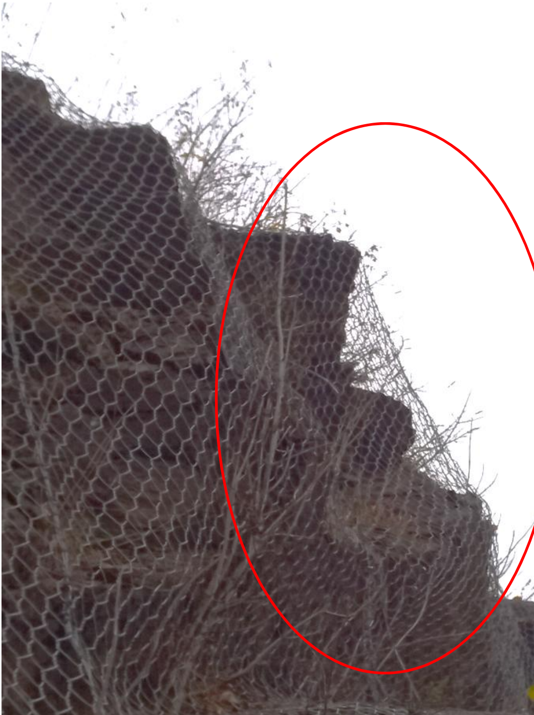
Obr. 18 Místa, kde síť nedostatečně kopíruje povrch terénu (převis) se vznikem tzv. „stanu“
