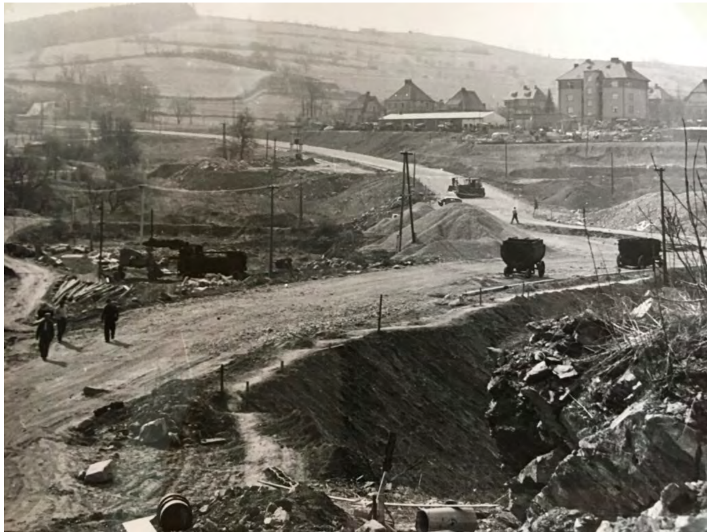
stavba Objížďkové ulice
