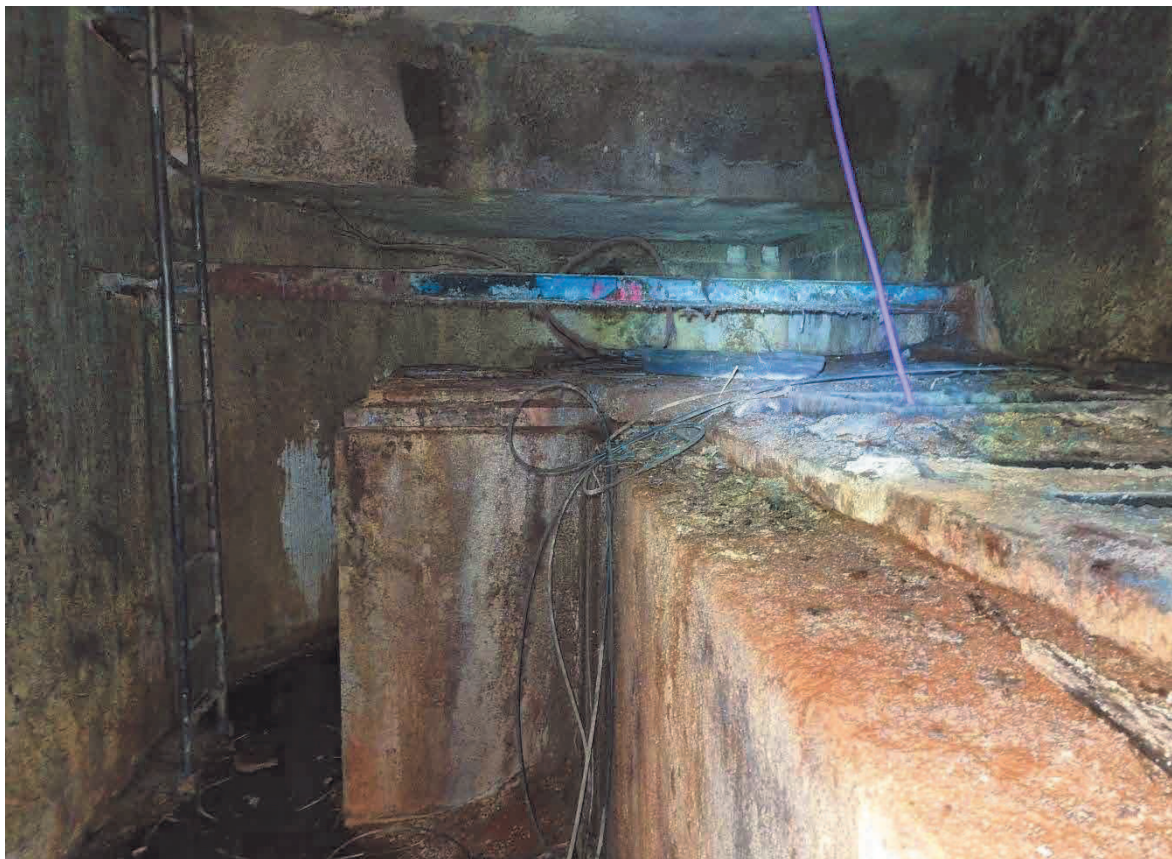
Obrázek 10: Obchvatný kanál Větrní - Č. Krumlov, konec Štoly IV s výstupní šachtou
