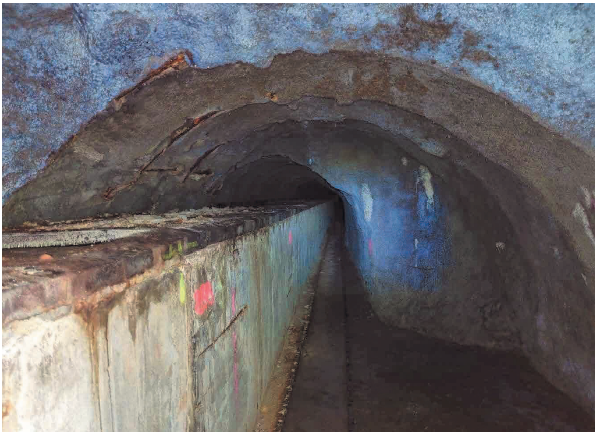
Obrázek 5: Obchvatný kanál Větřní - Č. Krumlov, Štola IV
