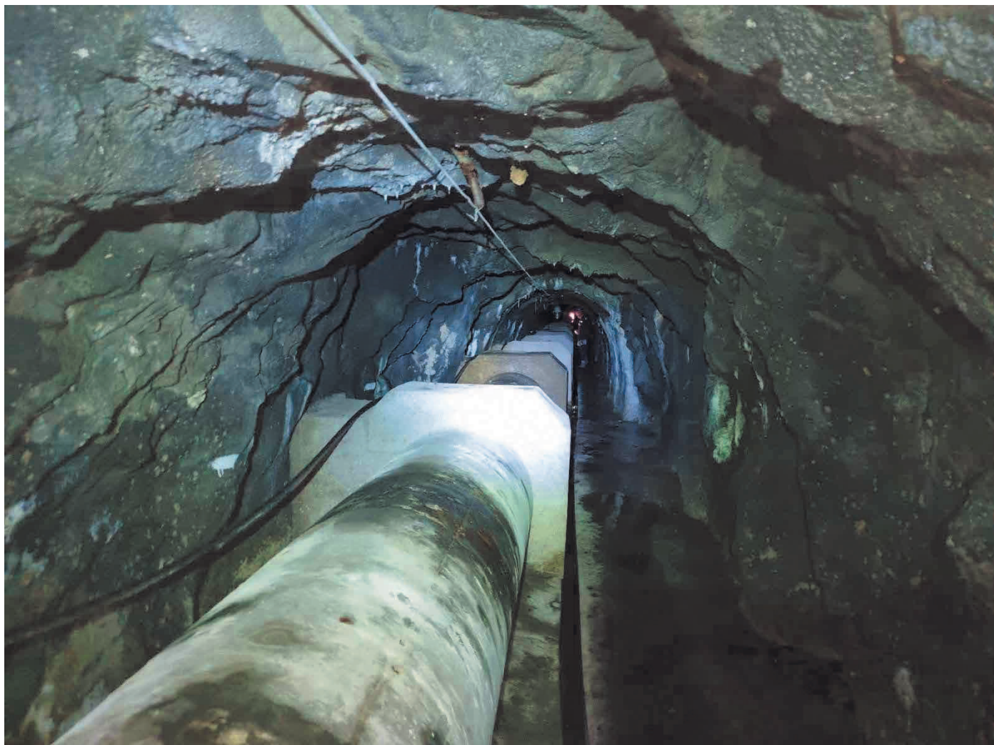
Obrázek 1: Obchvatný kanál Větřní - Č. Krumlov, Štola II
