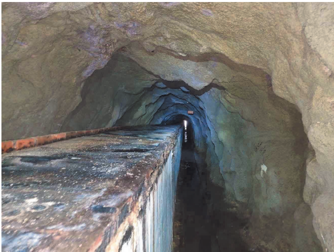
Obrázek 2: Obchvatný kanál Větrní - Č. Krumlov, Štola III
