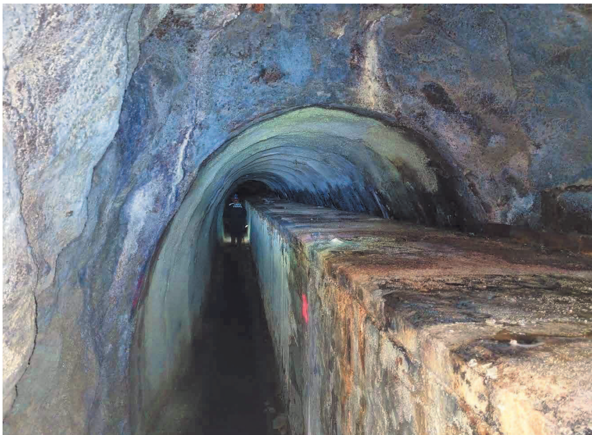
Obrázek 3: Obchvatný kanál Větrní - Č. Krumlov, Štola III
