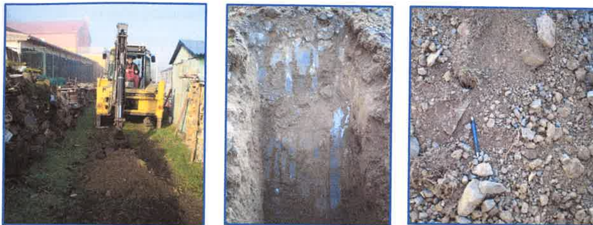
Foto 1, 2, 3: vyhloubená průzkumná sonda PS-1
