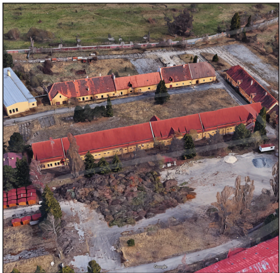
Letecký pohled na objekty_Google maps
