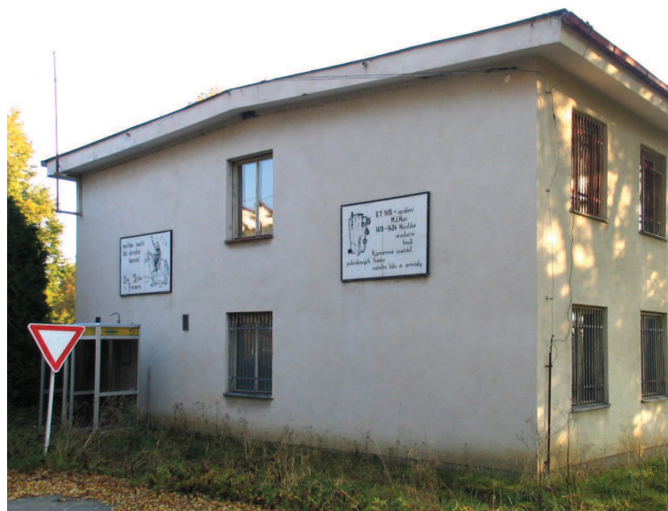
Budova bývalého velitelství - východní fasáda
