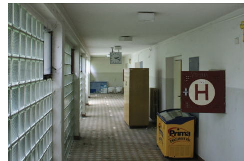
Chodba dílenského bloku
