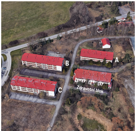
Letecký pohled na objekty_Google maps
