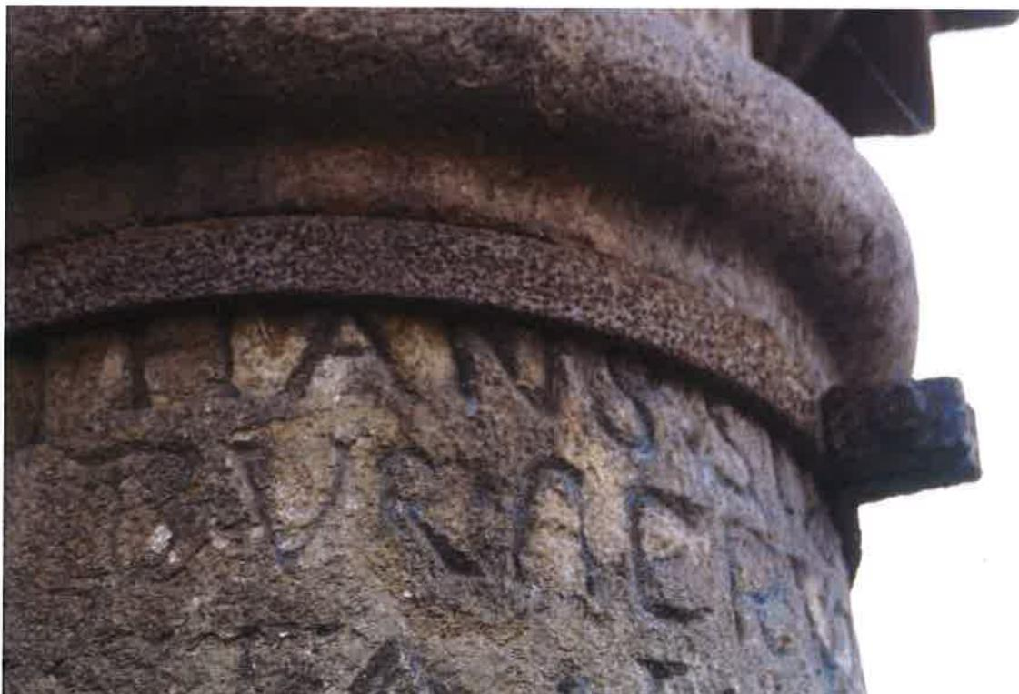
**Kamenná boží muka u čp. 78** - všechny kovové části - kovová jistící kramle, táhlo jsou silně celoplošně napadeny korozním procesem, způsobeným degradací a absencí nátěrových systémů a jehož korozní produkty dále kamenný materiál silně znečišťují; celkový pohled a detail táhla
