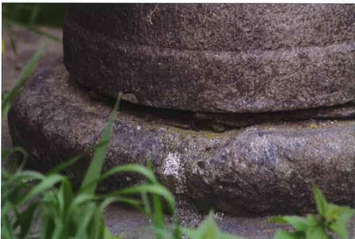
**Kamenná boží muka u čp. 78** - některé části muk – pohledově levý roh základny, prstenčitá patka, jsou dále mechanicky poškozeny např. odražením částí profilace a rohů, jejichž absence značně snižuje kvalitu celého díla; detail základny
