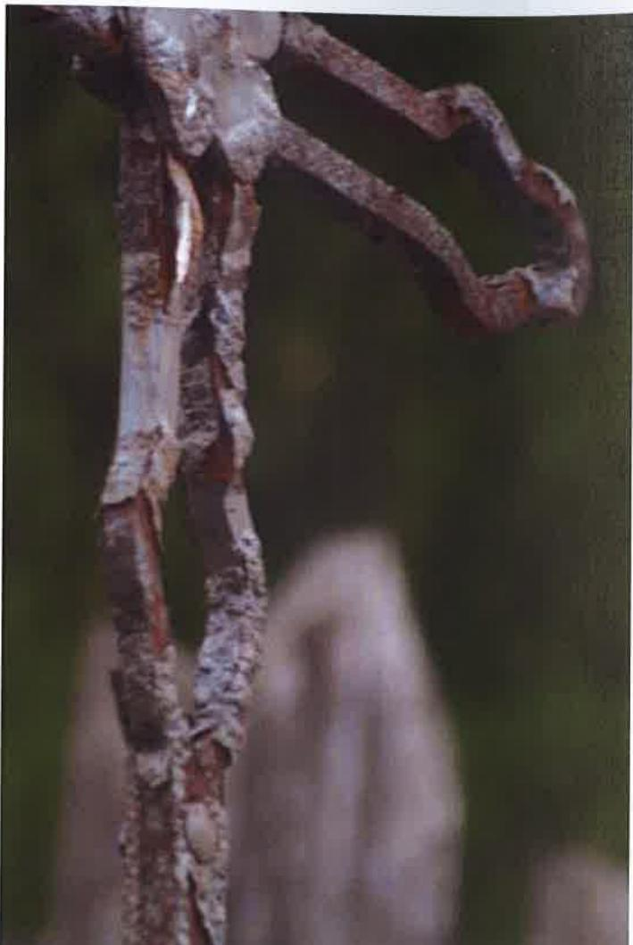
**Kamenná boží muka u čp. 78** - kovové části - vrcholový křížek jsou silně celoplošně napadeny korozním procesem, způsobeným degradací a absencí nátěrových systémů a jehož korozní produkty dále kamenný materiál silně znečišťují; celkový pohled a detail křížku
