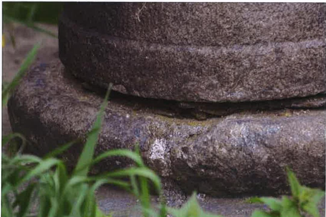
**Kamenná boží muka u čp. 78** - prvotní vizuální průzkum potvrdil vážné statické poškození rozestupování se dvou desek základny, zřejmě z důvodu neexistence stabilního základu a z důvodu absence jedné ze zajišťujících kovaných kramlí, další ze statických poškození je silná degradace spáry mezi prstenčitou patkou a dříkem sloupu, kde došlo k úplné ztrátě tmelu a navíc korozi kovových klínek použitých při osazování; detail základny
