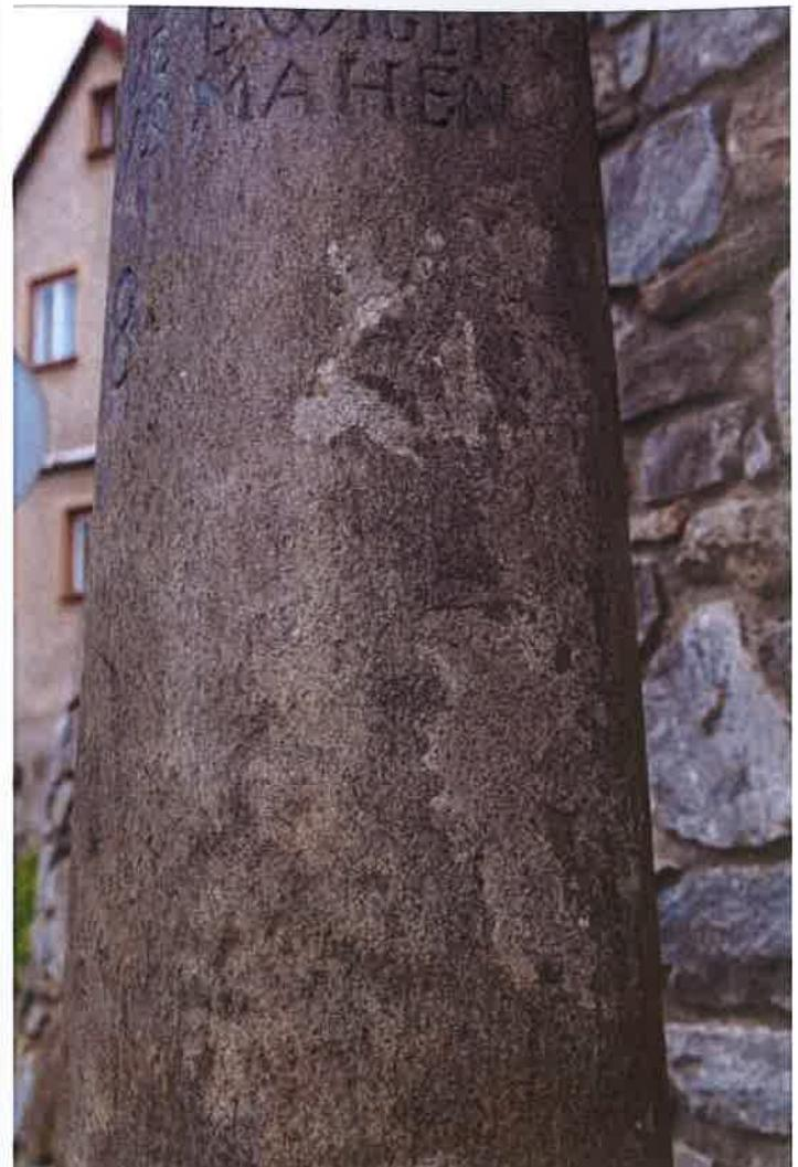
**Kamenná boží muka u čp. 78** - hmota díla je na mnoha místech poškozena degradací autentického materiálu, kdy lze celkovou degradaci kamenného materiálu kříže klasifikovat jako silná, tato degradace je nejvíce patrná na úbytku povrchové reliéfní vrstvý, kdy došlo k značné ztrátě plasticky sekaného písma v horní části dříku sloupu, v povrchových vrstvách dochází k lokální exfoliaci (lupínkování vrstev); detail pohledově levé a pravé strany dříku
