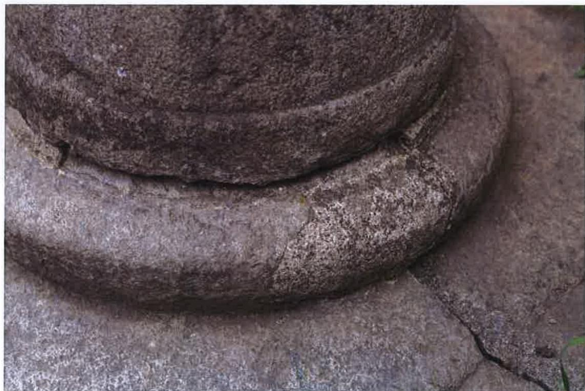
**Kamenňá boží muka u čp. 78** - lokálně jsou patrné tmely z minulých restaurátorských zásahů, které jsou již v současné době neodpovídají svou texturou ani strukturou, např. prstenčitá patka, na rozích kaplice, apod.; detail kaplice
