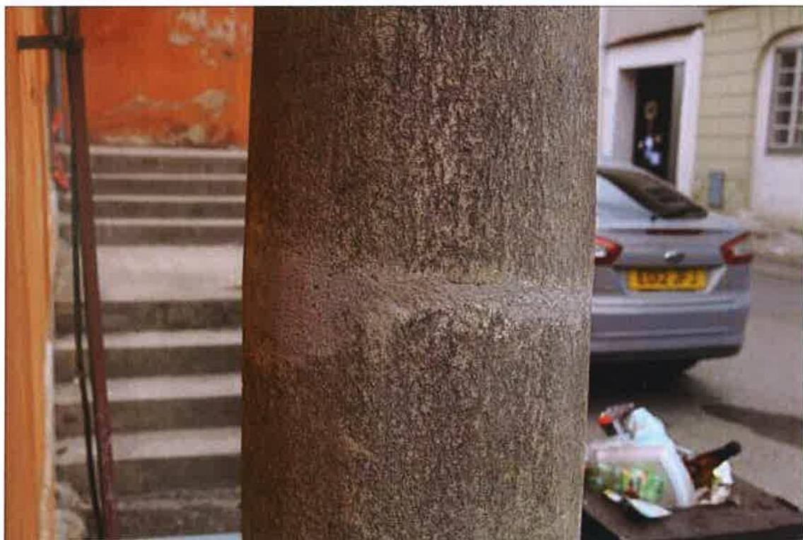
**Kamenná boží muka u čp. 74** - další vážné poškození bylo přelomení dříku sloupu a to zřejmě ve dvou výškových úrovních, kdy jsou na těle dříku patrné tmelené spáry v místech spojů, které již v současné době neodpovídají svou texturou ani strukturou; detail dříku
