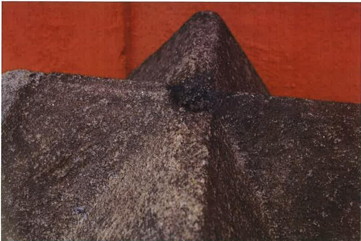
**Kamenná boží muka u čp. 74** - v místě křížení štítů sedel na kapli je patrný otvor po kotvení vrcholového kovaného křížku, který k datu průzkumu chybí; detail horní části kaplice
