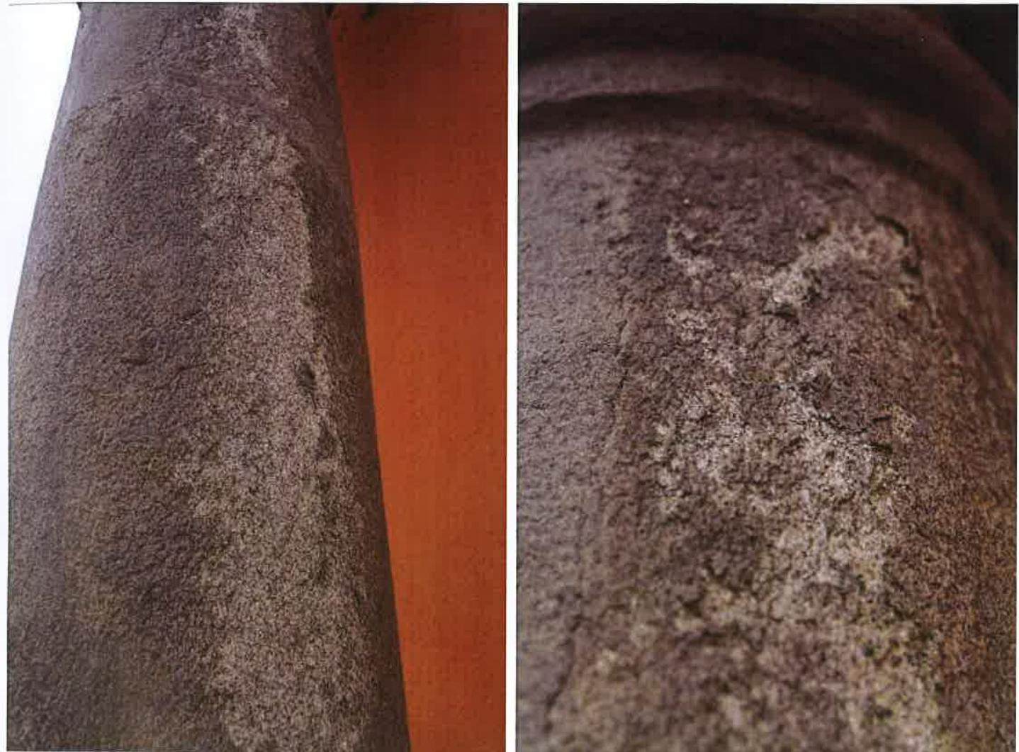
**Kamenná boží muka u čp. 74** - hmota díla je na mnoha místech poškozena degradací autentického materiálu, kdy lze celkovou degradaci kamenného materiálu kříženec klasifikovat jako silná, tato degradace je nejvíce patrná na úbytku povrchové reliéfní vrstvy; v povrchových vrstvách dochází k lokální exfoliaci (lupínkování vrstev); detail čelní strany dříku
