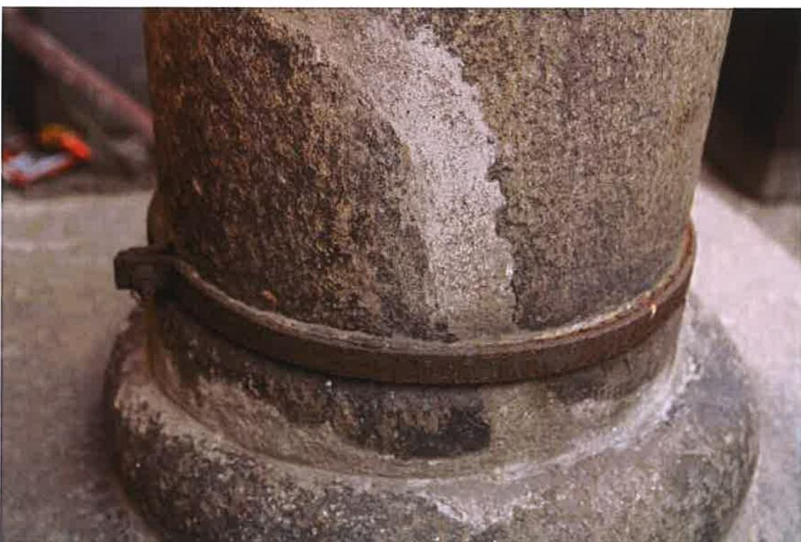
**Kamenná boží muka u čp. 74** - všechny kovové části – kovová obruč a jistící táhlo jsou silně celoplošně napadeny korozním procesem, způsobeným degradací a absencí nátěrových systémů a jehož korozní produkty dále kamenný materiál silně znečišťují; celkový pohled a detail táhla
