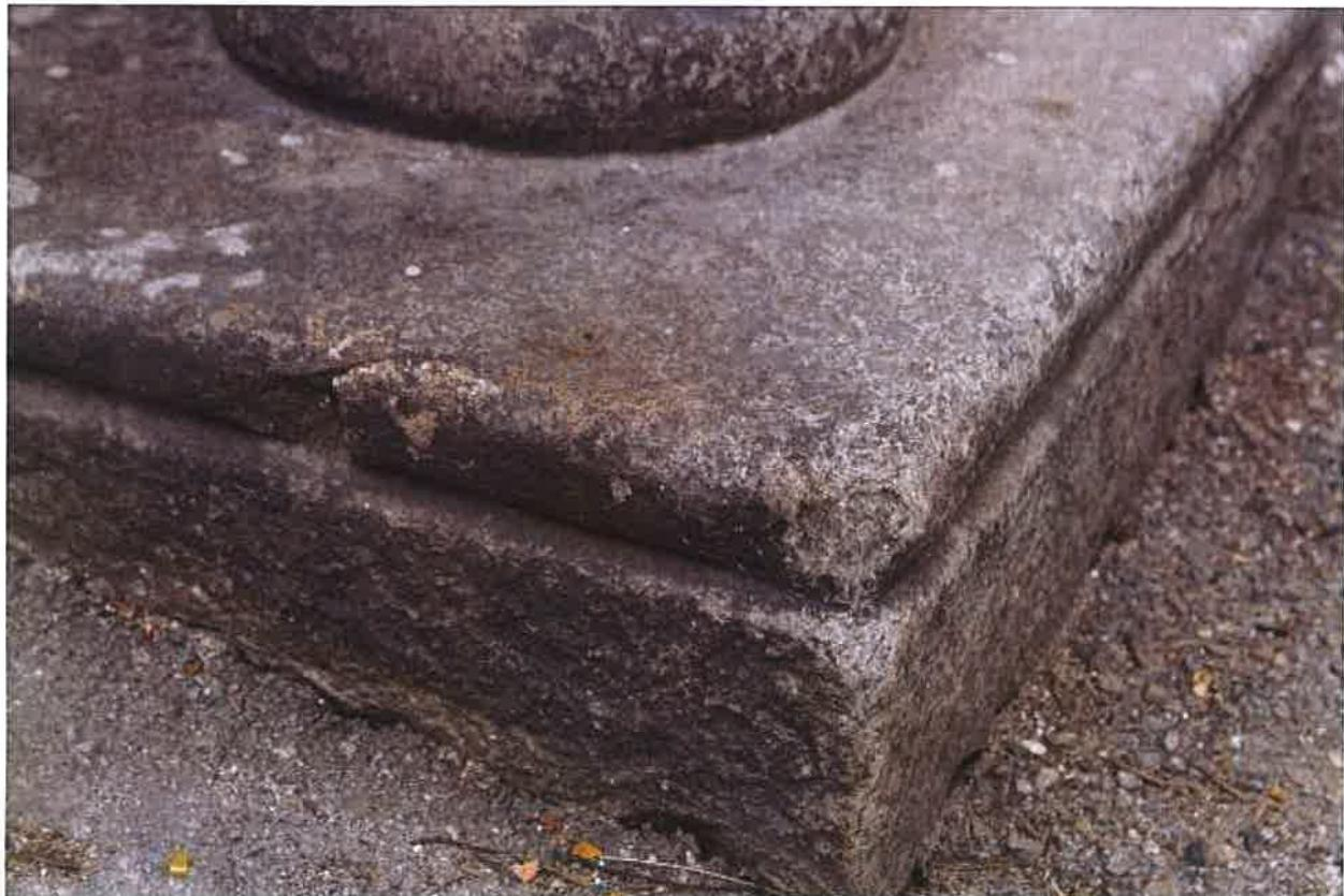
**Kamenná boží muka u čp. 74** - některé části muk – pohledově levý roh základny jsou dále mechanicky poškozeny např. odražením částí profilace a rohů, jejichž absence značně snižuje kvalitu celého díla; detail základny
