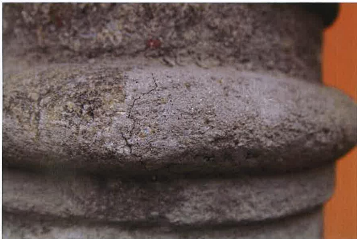
**Kamenná boží muka u čp. 74** - na profilaci hlavice jsou patrné tmely z minulých restaurátorských zásahů, které již v současné době neodpovídají svou texturou ani strukturou a lokálně dochází k jejich odpraskávání; detail hlavice sloupu
