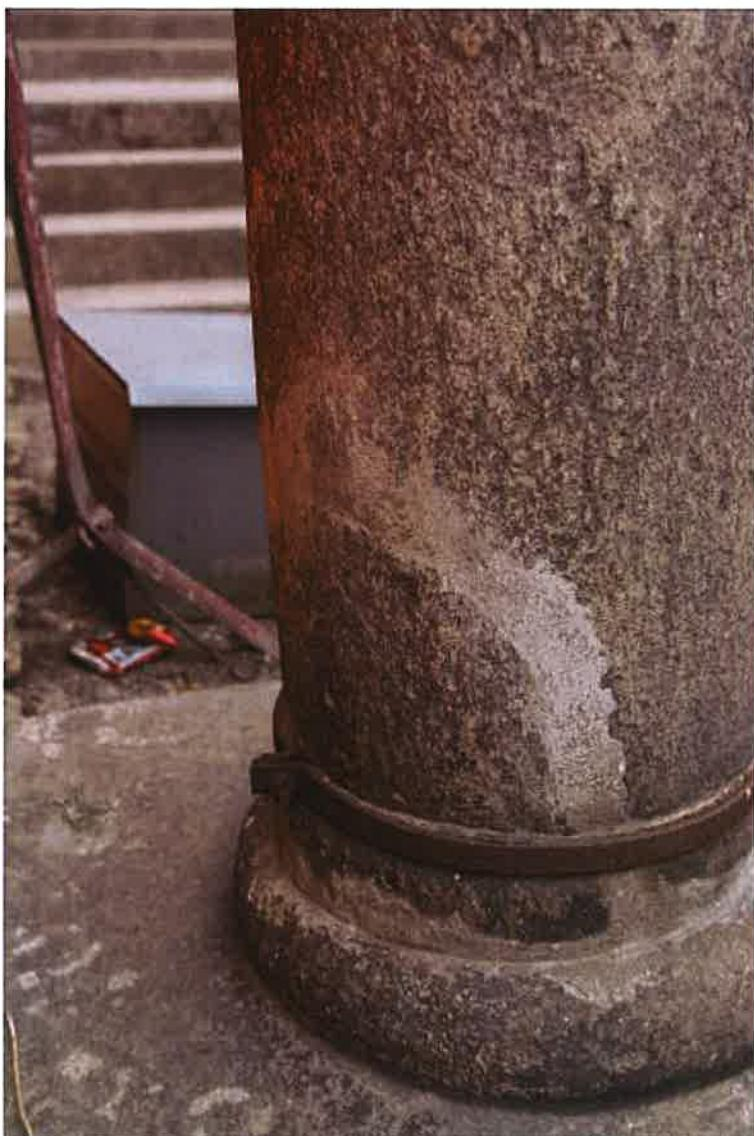
**Kamenná boží muka u čp. 74** - prvotní vizuální průzkum potvrdil vážné statické poškození odlomení dolní části dříku, který byl při některém z minulých restaurátorských zásahů stažen kovovou obručí, kdy jsou na těle dříku patrné tmelené spáry v místech spojů, které již v současné době neodpovídají svou texturou ani strukturou; detail dolní části dříku
