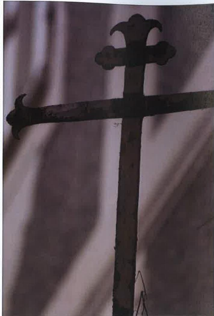
**Kamenná boží muka u čp. 271** - kovové části - vrcholový křížek jsou silně celoplošně napadeny korozním procesem, způsobený degradací a absencí nátěrových systémů a jehož korozní produkty dále kamenný materiál silně znečišťují; celkový pohled a detail křížku
