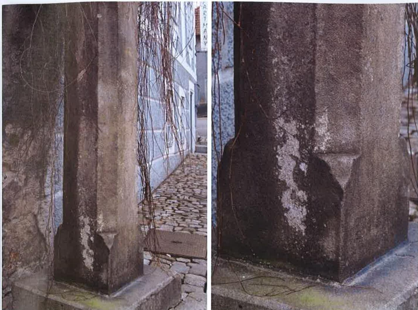
**Kamenná boží muka u čp. 271** - hmota díla je na mnoha místech poškozena degradací autentického materiálu, kdy lze celkovou degradaci kamenného materiálu kříže klasifikovat jako silná, tato degradace je nejvíce patrná na úbytku povrchové reliéfní vrstvy, kdy v povrchových vrstvách dochází k lokální exfoliaci (lupínkování vrstev); detail pohledově levé strany dříku
