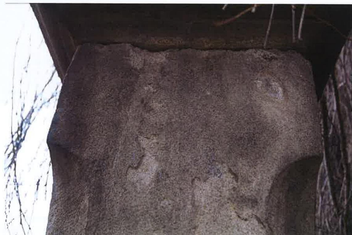
**Kamenná boží muka u čp. 271** - spárovací materiál mezi jednotlivými kamennými částmi je již silně degradovaný nebo již zcela chybí; detail dříku
