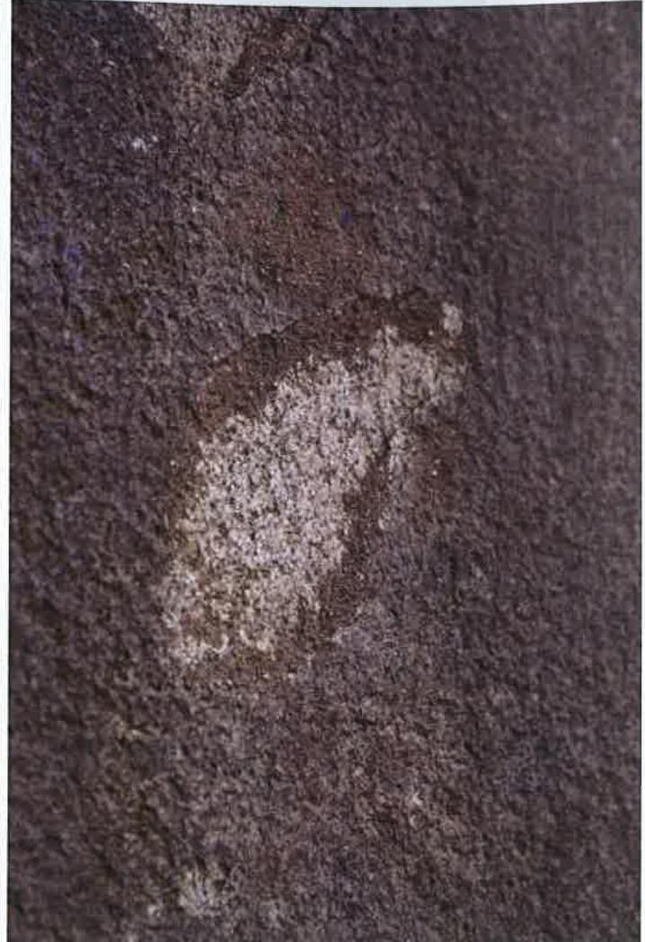
**Kamenná boží muka u čp. 271** - hmota díla je na mnoha místech poškozena degradací autentického materiálu, kdy lze celkovou degradaci kamenného materiálu klasifikovat jako silnou, tato degradace je nejvíce patrná na úbytku povrchové reliéfní vrstvy, kdy jsou na reliéfních okrajích odpadaných ploch dříku sloupu viditelné stopy jejich přitmelování; detail dříku
