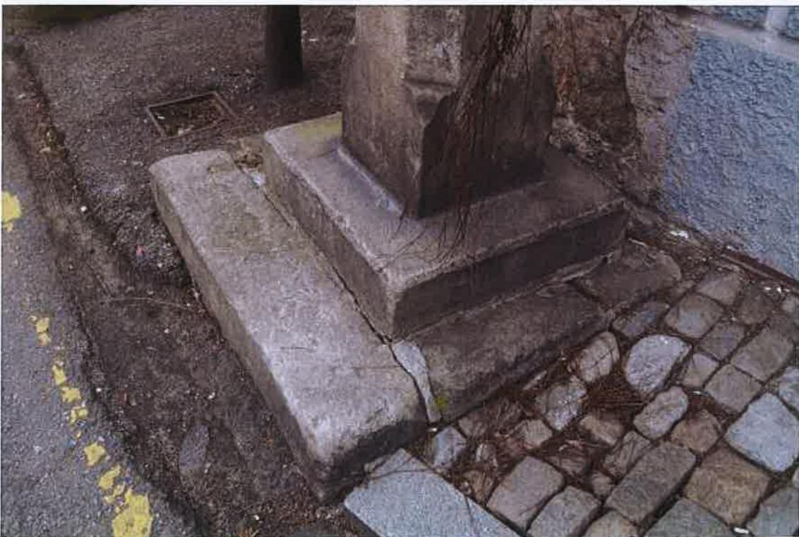
**Kamenná boží muka u čp. 271** - prvotní vizuální průzkum potvrdil vážné statické poškození rozestupování se jednotlivých kusů obvodového schodišťového stupně, zřejmě z důvodu neexistence stabilního základu a z důvodu absence jedné ze zajišťujících kovaných kramlí; detail základny
