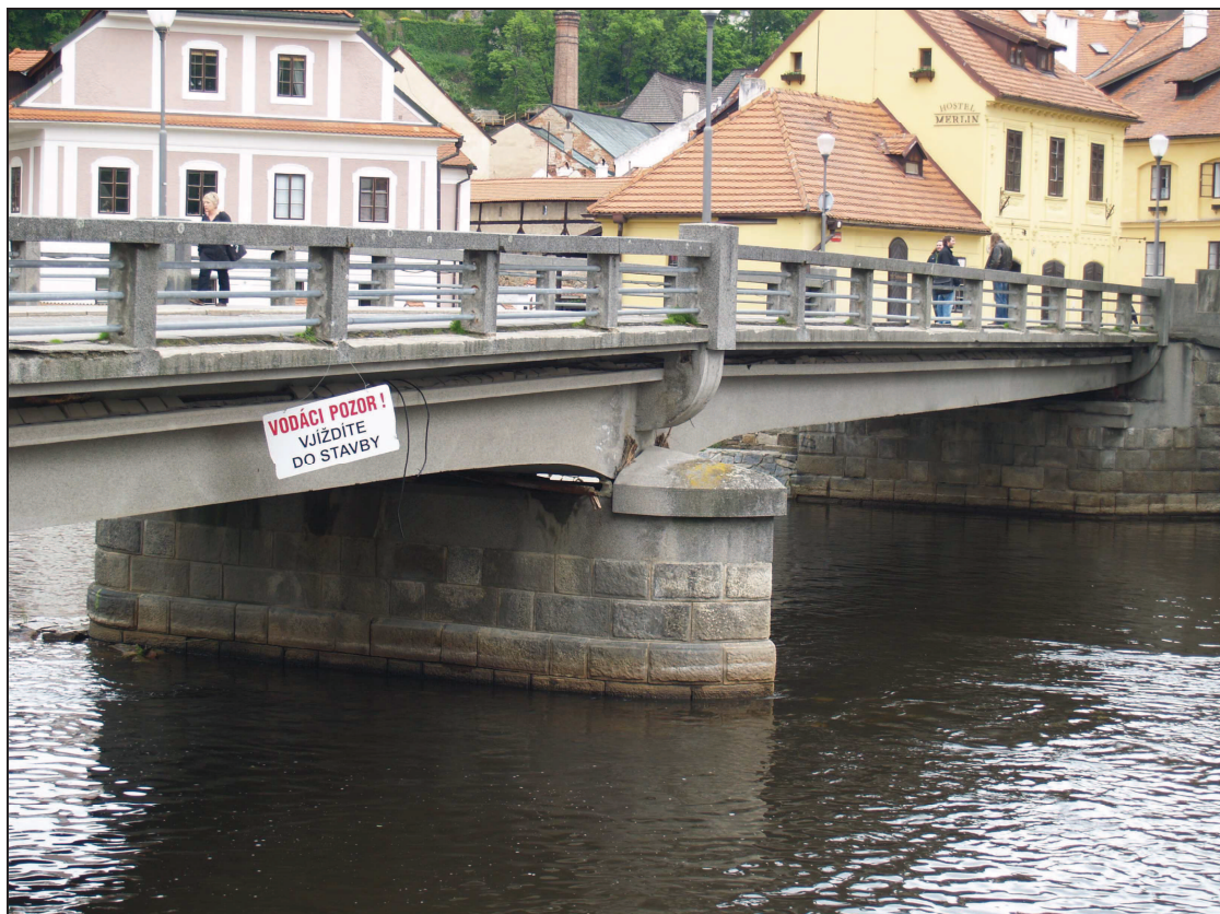
Detail středového pilíře, foto 2010 archiv NPÚ Č. Budějovice.
